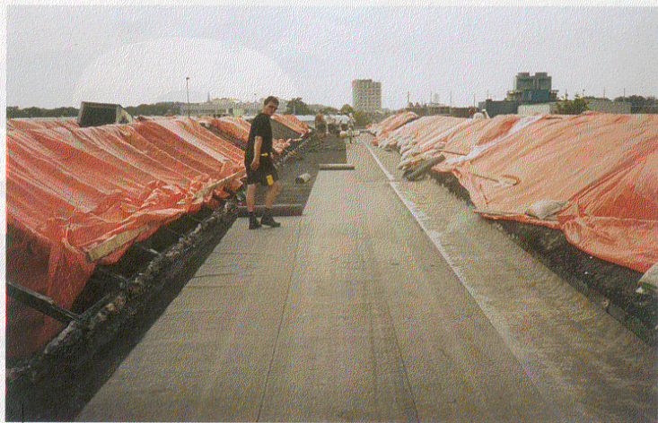
Het herstel was eenvoudig: een nieuwe bitumen onderlaag volledig gegoten op de intact gebleven isolatielaag.
